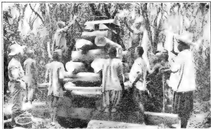
Billes dont plusieurs millions furent préparées pendant la guerre pour l'achèvement de certains tronçons de chemins de fer.
